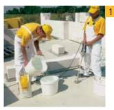
Для подготовки раствора YTONG® для тонкошовной кладки требуются простые инструменты: электродрель с установленной перемешивающей лопастью. пластиковая емкость для размешивания раствора и вода.
