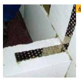
Анкеровка дополнительно возводимой перегородки. Гибкие связи крепятся к несущей кладке дюбелем. Для крепления перегородок к перекрытиям используются гибкие связи кладки или монтажная пена.
