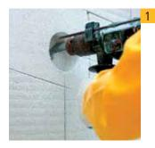
Отверстия для электрических розеток и выключателей высверливаются при помощи безударной низкооборотной дрели с нужной насадкой.
