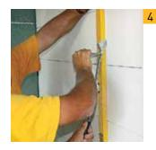
При помощи штробореза очень просто изготавлять каналы для прокладки электропроводки и / или водоносной трубы.
