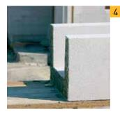
Вертикальные швы между . U-образными блоками раствором заполняются YTONG® для тонкошовной кладки блоков.
