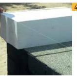
Между установленными угловыми блоками растягиваем шнур-причалку и заполняем ряд. Если расстояние между углами превышает 10 метров, то между угловыми блоками устанавливается дополнительный блок, за который закрепляется шнур. Данная мера предотвратит его провисание. Заполняем первый ряд.
