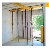
Балки на время монтажа и бетонирования должны иметь промежуточные временные опоры - телескопические стойки и профильные трубы 80х40х3 мм в качестве подпорных реек. Несущая способность перекрытия, на которое передают нагрузку временные опоры, должна быть не менее 400 кг/м<sup>2</sup>
