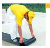
Перед тем как приступить к кладке стен, следует выполнить гидроизоляцию фундамента. Очистите поверхность фундамента щеткой, уложите рулонный гидроизоляционный материал. Соединение полос производится с нахлестом не менее 150 мм.
