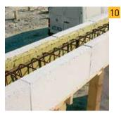
Изображение правильно подготовленной перед бетонированием перемычки из U-образных блоков YTONG®.
