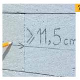
Длина крайних блоков, например, на краях (дверных и оконных) проемов или углов здания должна быть , ≥ 11,5 см.
