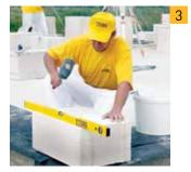
Горизонтальное и вертикальное положение блоков контролируется с помощью уровня и при необходимости корректируется резиновым молотком.
