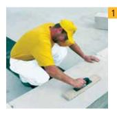
Проверяем кладку в месте будущей стены; имеющиеся неровности устраняем рубанком. Тщательно очищаем поверхность кладки от пыли и загрязнений!
