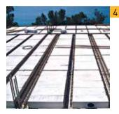
Если толщина внутренних несущих стен меньше 25 см. не рекомендуется укладывать балки в одну линию. При большей толщине стены балки можно укладывать в одну линию.
