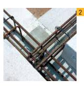
Монолитный пояс укладывается в уровне перекрытия и бетонируется одновременно с перекрытием. Продольную арматуру пояса необходимо последовательно связывать внахлест (длина нахлеста минимум 900 мм), также возможна сварка. Особо важной является стыковка арматуры в углах.
