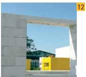
Если перемычки укладываются на блоки со стандартной высотой, то для достижения требуемой высоты стены может потребоваться выравнивающий слой из блоков.
