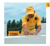
Имеющиеся неровности кладки устраняем при помощи шлифовальной доски или рубанка. Мелкие загрязнения и пыль удаляем щеткой.
