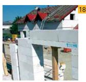
Перемычки приобретают несущую способность после затвердевания раствора YTONG® для тонкошовной кладки. После затвердевания раствора поддержка монтажа может быть удалена.
