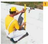
В соответствии с проектом дома обозначаем на несущей стене место для будущей перегородки. Разметка должна быть строго перпендикулярна фундаменту.
