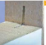
Соединение стены, заполняющей каркас, с ж/б колонной или перпендикулярной ж/б стеной выполняется при помощи металлических связей, располагаемых через каждые 2-3 слоя блоков YTONG®. При этом одна часть связи помешается в шве кладки из блоков и крепится специальными гвоздями, а вторая часть крепится к боковой поверхности столба или стены.
