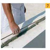
Вкладываем в паз стальной стержень (арматуру), лучше всего — из профилированной стали диаметром не менее 6 мм.
