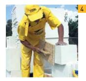
Чтобы получить гладкую поверхность и обеспечить хорошее сцепление раствора с блоком, поверхность блока выравниваем рубанком или шлифовальной доской.
