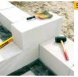
Деталь связки внутренней и наружной стен. При кладке используется инструмент YTONG®.
