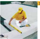
Несущая внутренняя стена связывается с наружной стеной кладкой при помощи перевязки. Первый ряд блоков кладется цементно-песчаный раствор толщиной не менее 20 мм. При этом необходимо постоянно проверять совпадение уровней стен по горизонтали.
