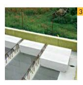
Т-образные блоки первого (от стены) ряда сборно-монолитного перекрытия опираются одной стороной на балку, а другой на стену или ригель. Минимальная зона опоры составляет 20 мм. Размеры блоков перекрытия разрешается корректировать путем распиливания. Блок с обработанным линейным размером всегда укладывается только крайним поверх стены с выносом минимум 20 мм.
