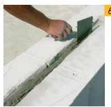
Заполняем цементным раствором подготовленный паз до половины глубины. Для этого можно использовать и раствор YTONG® для тонкошовной кладки блоков.
