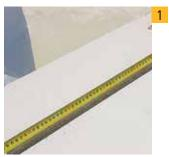
Под предполагаемым окном в предпоследнем ряду блоков следует монтировать горизонтальную арматуру. Обозначаем на поверхности блоков планируемую длину оконных проемов. Длина арматуры должна быть длиннее оконного проема не менее чем на 0,5 м с каждой стороны.
