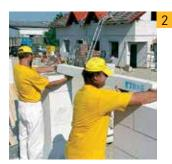
Для наружной стены толшиной 50 см можно использовать две перемычки шириной 175 мм и перемычку с шириной 150 мм. (Альтернативно — четыре перемычки с шириной 125 мм)
