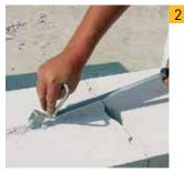
При помощи ручного штро-бореза YTONG® в средней части кладки блоков делаем пазы, соответствующие длине арматуры.
