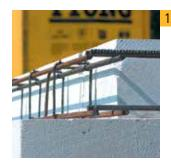
В перекрытиях длиной до 6 метров для армирования монолитного пояса монтируем минимум 3 продольных стержня ⊘ 10 мм. Диаметр проволоки для хомутов = 4,5 мм, расстояние между хомутами = 250 мм.
