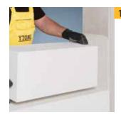
Часто однослойные стены из блоков YTONG® используются как заполнение железобетонного каркаса. При этом места примыкания блоков к железобетону заполняются цементно-песчаным раствором.
