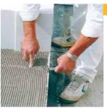
Гибкие связи кладки можно монтировать в слой раствора и без гвоздей — путем вдавливания.
