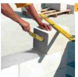
Раствор также наносится на вертикальную поверхность блока посредством прижатия кельмы к нижней части вертикальной стенки блока и перемещением ее вверх, не отрывая.
