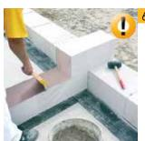
Раствор также наносится на вертикальную поверхность блока.
