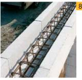
Арматурные каркасы укладываются ближе к внутренней грани U-перемычки.
