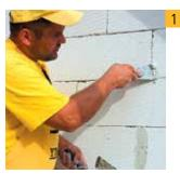
Образовавшиеся при кладке блоков щели или неровности заполняем раствором, который получаем при смешивании раствора для тонкошовной кладки YTONG® с пылью, оставшейся после резки блоков YTONG®, или специальным раствором, предназначенным для этой цели.
