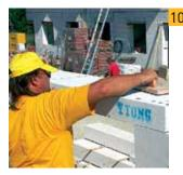
Неровности на поверхности перемычек выравнива-ются рубанком YTONG®.
