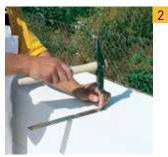
В месте, где будет перегородка, в клеевой шов вкладывается гибкая связь из нержавеющей стали. Анкеры одним концом монтируются в несущую стену, а другим концом — в шов перегородки.
