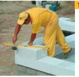
Кладку несущих стен начинаем с закладки угловых блоков. Каждый уложенный блок требует выравнивания не только по горизонтали, но и по вертикали.
