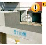
Блоки укладываются на перемычку на раствор YTONG® для тонкошовной кладки. Вертикальные стыки при этом также осуществляются с применением тонкошовного раствора (вне зависимости от наличия системы «паз-гребень»).
