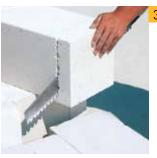
Чтобы распил получился более точным, необходимо отметить карандашом линию резки на двух сторонах блока — горизонтальной и вертикальной.
