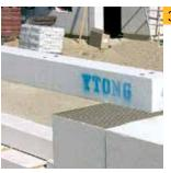
Перемычка укладывается так. чтобы напечатанная на ней стрелка указывала вверх.
