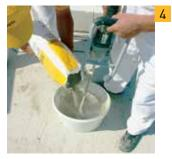
Рекомендуется затворить водой сразу весь мешок раствора. Этого количества готовой смеси хватает для возведения приблизительно 1,5 м<sup>3</sup> кладки газобетонных блоков
