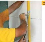
Наносим на стену линии прокладки внутренней проводки и коммуникаций. Для получения прямолинейных пазов прибиваем к стене направляющую доску. Пазы удобнее всего сделать с помощью ручного штробореза YTONG®, который направляется вдоль доски YTONG®.
