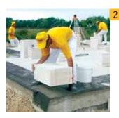
Первым закладывается блок в самом высоком углу здания, уровень которого определяется с помощью нивелира. Разница по высоте отдельных углов дома не должна превышать 30 мм.
