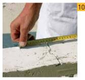
Приступаем к кладке очередного ряда блоков, который будет находиться непосредственно под оконным проемом. При этом необходимо следить за перевязкой блоков минимум на 10 см.
