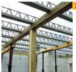
При отсутствии инвентарных телескопических стоек допускается использовать деревянные монтажные опоры в виде столбов диаметром 140-160 мм или брусков. Профильные металлические трубы допускается заменять подпорными рейками из досок сечением не менее 50х120 мм (или бруски размером не менее 100х100 мм), установленными горизонтально ребром вверх и закрепленными на опорных столбах или инвентарных телескопических стойках.
