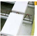
Первый и последний блоки перекрытия между двумя балками должны быть подогнаны к внутреннему краю опорной стены. Возможен вынос блока на стену при соблюдении достаточной ширины и армирования монолитного пояса, определенных проектом.
