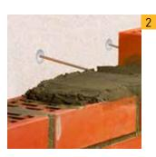
Крепление ограждающей кирпичной кладки к стене из газобетонных блоков YTONG® осуществляется при помощи специальных анкеров с передвижными шайбами, способными отводить конденсат.
