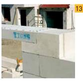
Также перемычка может быть уложена на блоки с предварительным выпилом. Глубина опирания не менее 250 мм.
