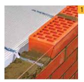
При строительстве многослойных стен кладка ограждающей стены (как правило, из кирпича) крепится к несущей стене из блоков YTOŃG® при помощи гибких анкеров. Анкеры выполняются из нержавеющей или оцинкованной стали и устанавливаются из расчета всреднем не менее 5 шт. на 1 кв. м. Анкер размещается в шве между блоками YTONG® в процессе кладки стены, а затем, при возведении кирпичной стенки, отгибается и заводится в соответствующий шов кирпичной стены.
