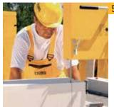
При строительстве многоэтажных домов для резки блоков рекомендуется использовать ленточную электропилу, которая oбеспечит быстроту и безопасность резки. Блоки размещаются на передвижном столе пилы.
