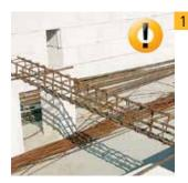
U-образные блоки YTONG® являются элементами опалубки для железобетона. Железобетонная часть должна иметь соответствующее проведенным расчетам армирование. Для армирования лучше всего подходит пространственный арматурный каркас.
