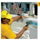
Положение перемычки регулируется при помощи резинового молотка.
