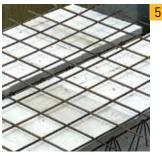
После монтажа сборных элементов перекрытия на верхние стержни арматуры балок укладывается арматурная сетка 100х100х5 мм. Ее положение, высота установки и связь с верхней арматурой балки определяется проектом. Стыковка отдельных сеток между собой осуществляются с нахлестом шириной не менее 150 мм
