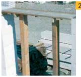
U-образные блоки YTONG® укладываются на подготовленное горизонтальное основание. Эту функцию отлично выполняет доска или брус. Основание должно иметь надежную опору, чтобы во время заливки перемычка не прогибалась.
