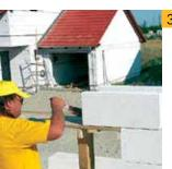
U-образные блоки YTONG® укладываются на подготовленное основание так, чтобы глубина опирания перемычки составляла не менее 250 мм
