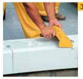
Наносим раствор YTONG® для тонкошовной кладки на горизонтальную поверхность блока с помощью кельмы YTONG® coответствующей ширины, затем, перевернув кельму, равномерно распределяем по всей поверхности блока.
