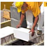
T-образные блоки YTONG® укладываются вручную вдоль продольного направления балок. Зазор между соседними блоками должен быть минимальным
