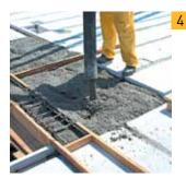
Бетонирование перекрытия ведется захватками. Ширина захватки не менее 620 мм.
