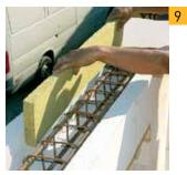
Между внешней стенкой U-перемычки и арматурным каркасом вкладывается теплоизоляция.
