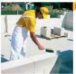
Имеющиеся неровности кладки устраняем при помощи шлифовальной доски или рубанка. Мелкие загрязнения и пыль удаляем щеткой.
