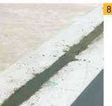
После погружения стержня в цементный раствор полностью заполняем паз раствором, при необходимости удаляем мастерком его излишек. Выравниваем поверхность кладки, удаляем щёткой загрязнения и пыль.
