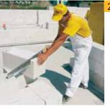
При строительстве частных домов резку блоков YTONG® проще всего осуществлять ручной ножовкой YTONG®.
